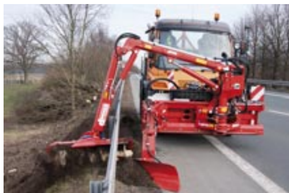
BRS 15 im Einsatz an Leiteinrichtungen
