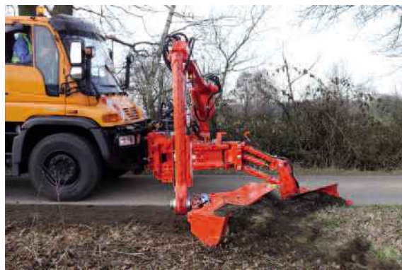
Banketträumschnecke BRS 15 im Einsatz
