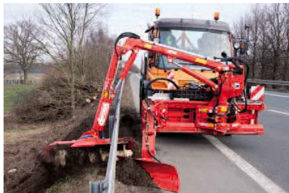
BRS 15 im Einsatz an Leiteinrichtungen
