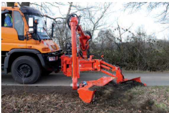
Banketträumschnecke BRS 15 im Einsatz
