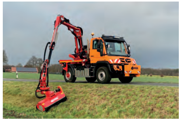
Der DAM 1050 beim Mähen einer Böschung
